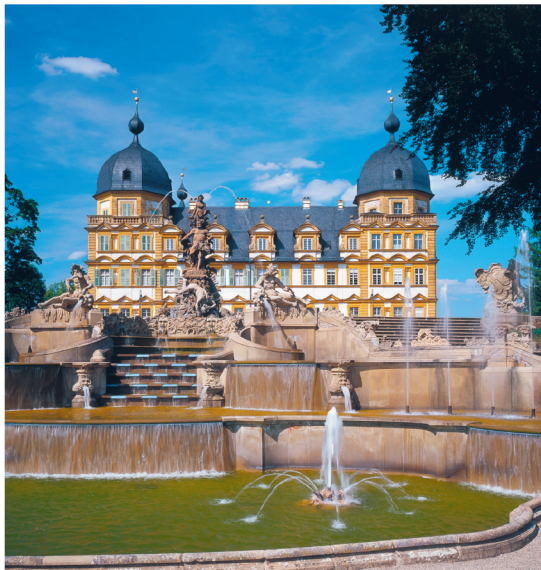
Schloss Seehof bei Bamberg, Oberfranken - Seehof Castle near Bamberg, Upper Franconia - Château Seehof près de Bamberg, Haute-Franconie - Castello Seehof presso Bamberg, Alta Franconia - Foto Reinhard Schmidt/Alamy Images
